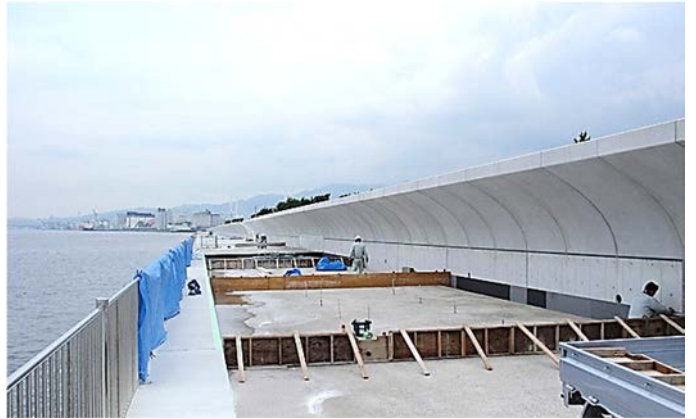
南護岸（上部工）
