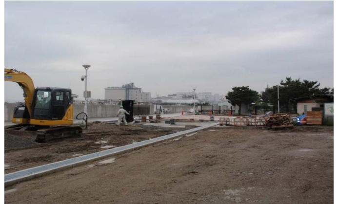
潮芦屋緑地西駐車場周辺（周辺整備工事（その2））
