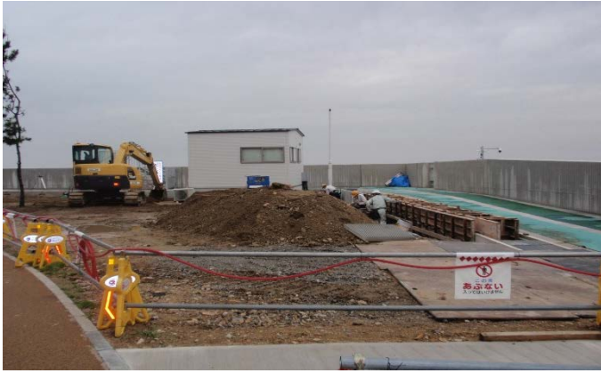
南護岸（周辺整備工事（その1））
