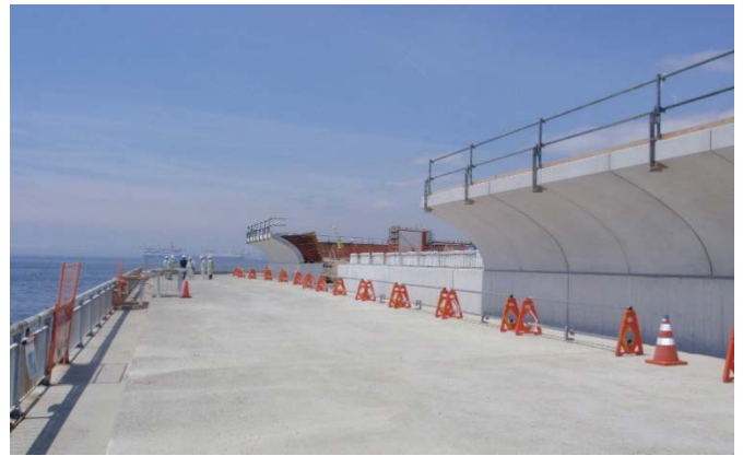
東護岸等（その12工区付近）
