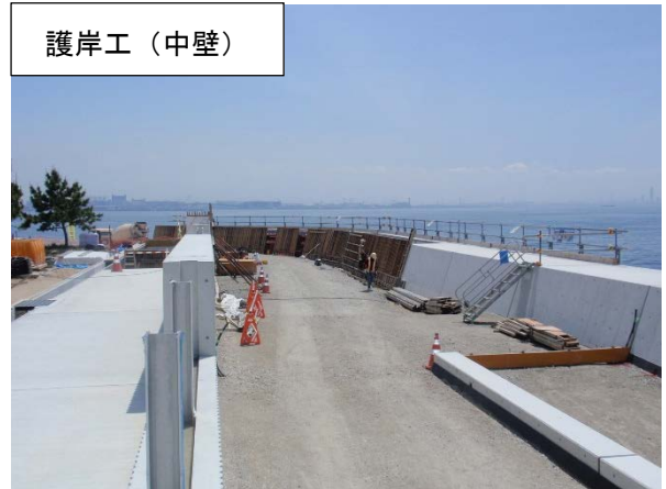
東護岸等（その11工区付近）
