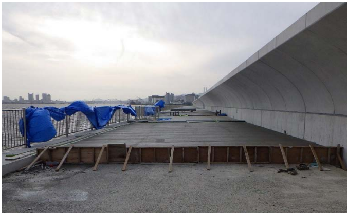
南護岸（上部工打設）
