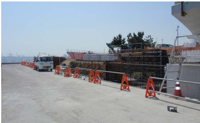
東護岸等（その12工区付近）
