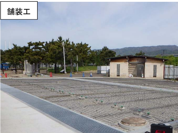
潮芦屋緑地西駐車場周辺（周辺整備工事（その2））
