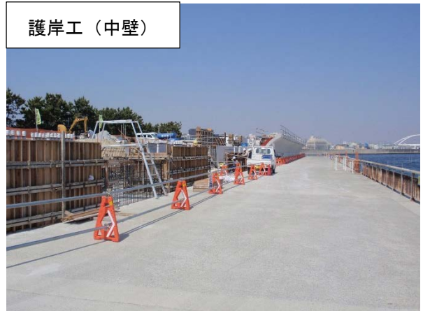
東護岸等（その11工区付近）
