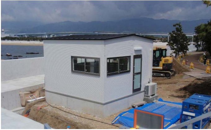
南護岸（周辺整備工事（その1））
