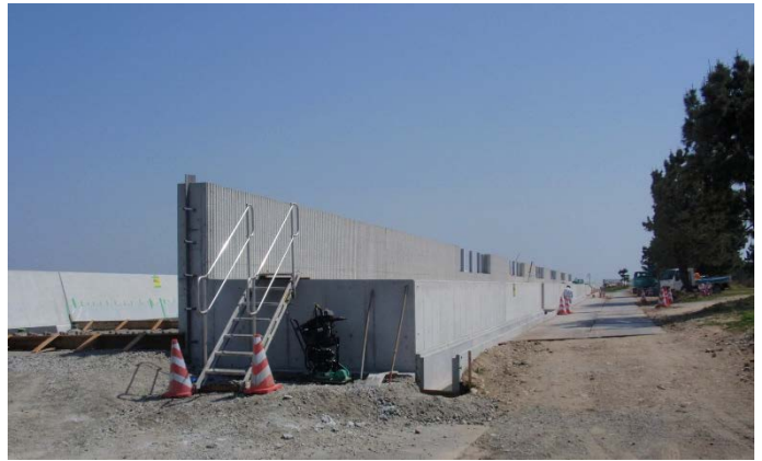
東護岸等（その2工区付近）
