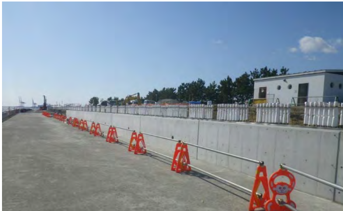
東護岸等（その11工区付近）
