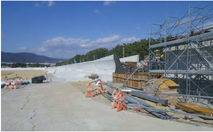
ビーチ護岸（その7工区付近）
