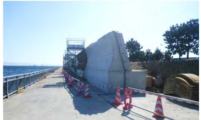
東護岸等（その2工区付近）
